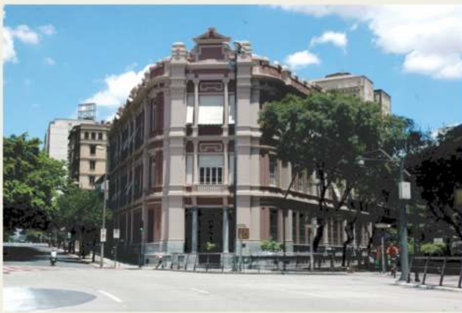
Antigo Prédio do Bemge (actual UAI), na Praça Sete, em Belo Horizonte
